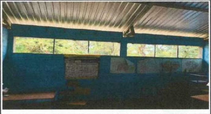
Foto 2: SUSTITUCION DE VENTANA DE MADERA CON MALLA A BALCONES DE METAL, EN LA PARTE TRASERA
