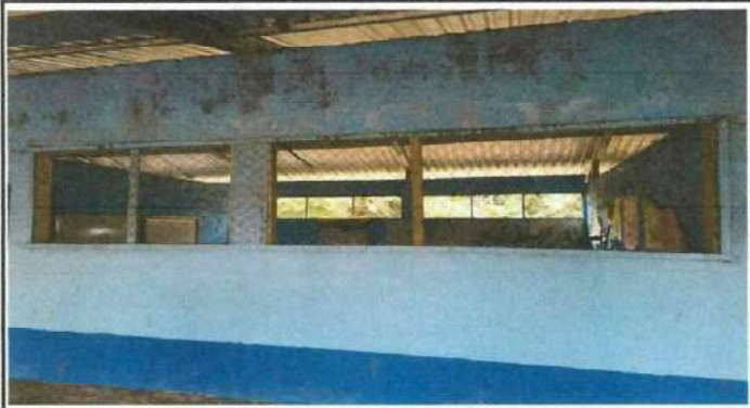
Foto1: SUSTITUCION DE VENTANA DE MADERA CON MALLA A BALCONES DE METAL, EN LA PARTE FRONTAL
